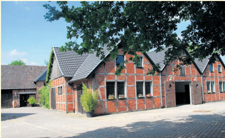
450 Jahre alte, liebevoll restaurierte Hofanlage
